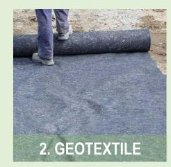
Séparation des couches À l'aide d'un feutre géotextile
