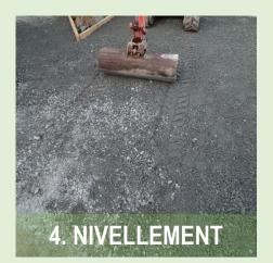
Nivellement précis 4 cm sous le niveau fini.
