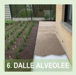
Dalle alvelolée 3cm Stabilise les graviers (Option simple geotextile)
